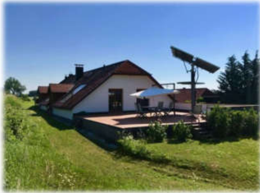
Die Solaranlage - ein Teil des nachhaltigen Betriebskonzeptes
